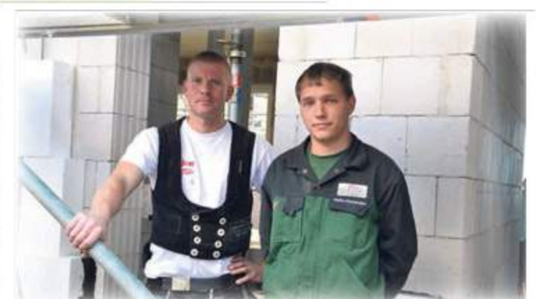
Der Zimmermeister Heiko Meyer (li.) sprach den Richtspruch, Zimmerer Malte Stemmann stand ihm zur Seite Fotos: ah
